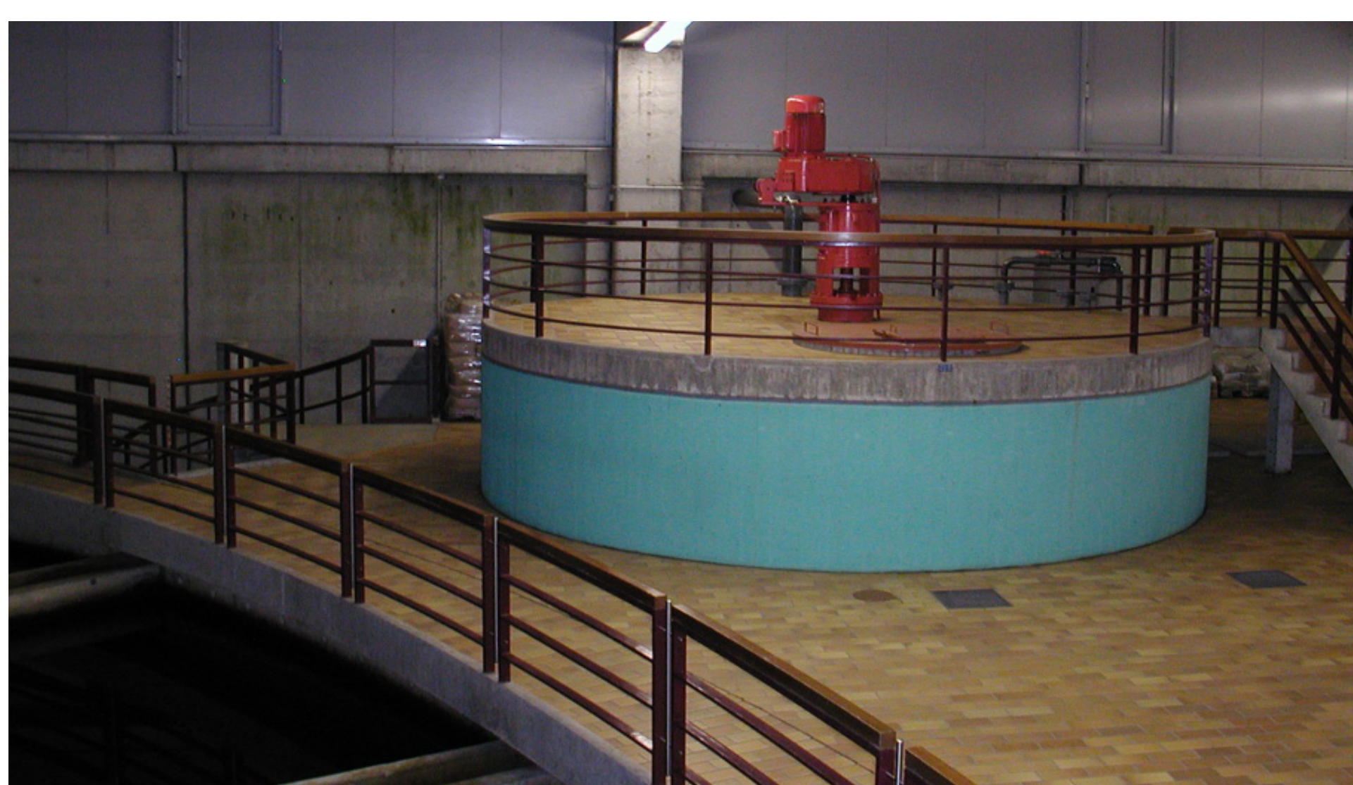
Abb. 1: Flockungssedimentationsanlage im Wasserwerk Langenau - Vormischer für Flockungsmiteleintrag
