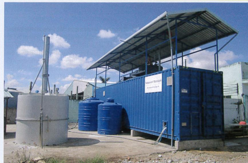
Bild 7 Pilotanlage zur anaeroben Abwasserbehandlung mit Biogasgewinnung
