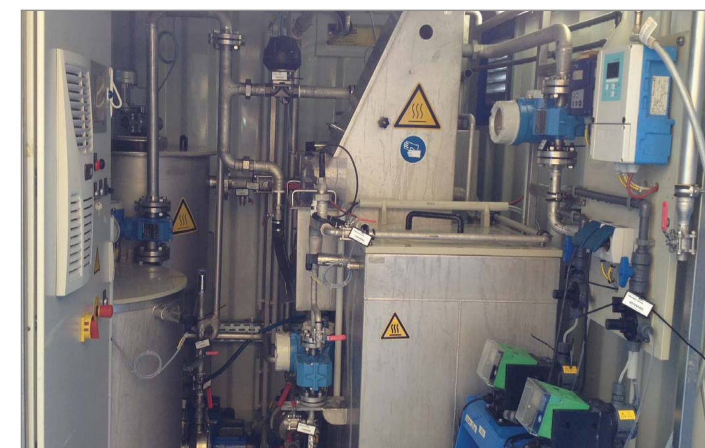
Abbildung 2: Pilotanlage am Standort der vietnamesischen Brauerei
