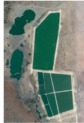
Abwasserteichanlage in Nord-Namibia ( www.google.de )
