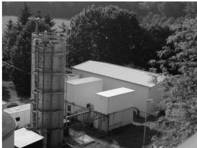
Abbildung 1-1: Überblick über die Versuchsanlagen in Eberstadt
